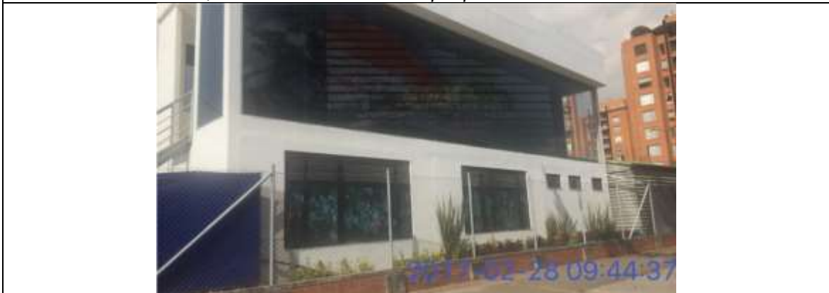
Fotografía No. 2 Vista de la publicidad del elemento no regulado constituido por pantallas publicitarias encontradas al interior de la edificación tipo estructura metálica montada sobre pilares y con fachada en vidrio con orientación hacia la vía pública, instalado sin autorización por parte de la Secretaría Distrital de Ambiente.
